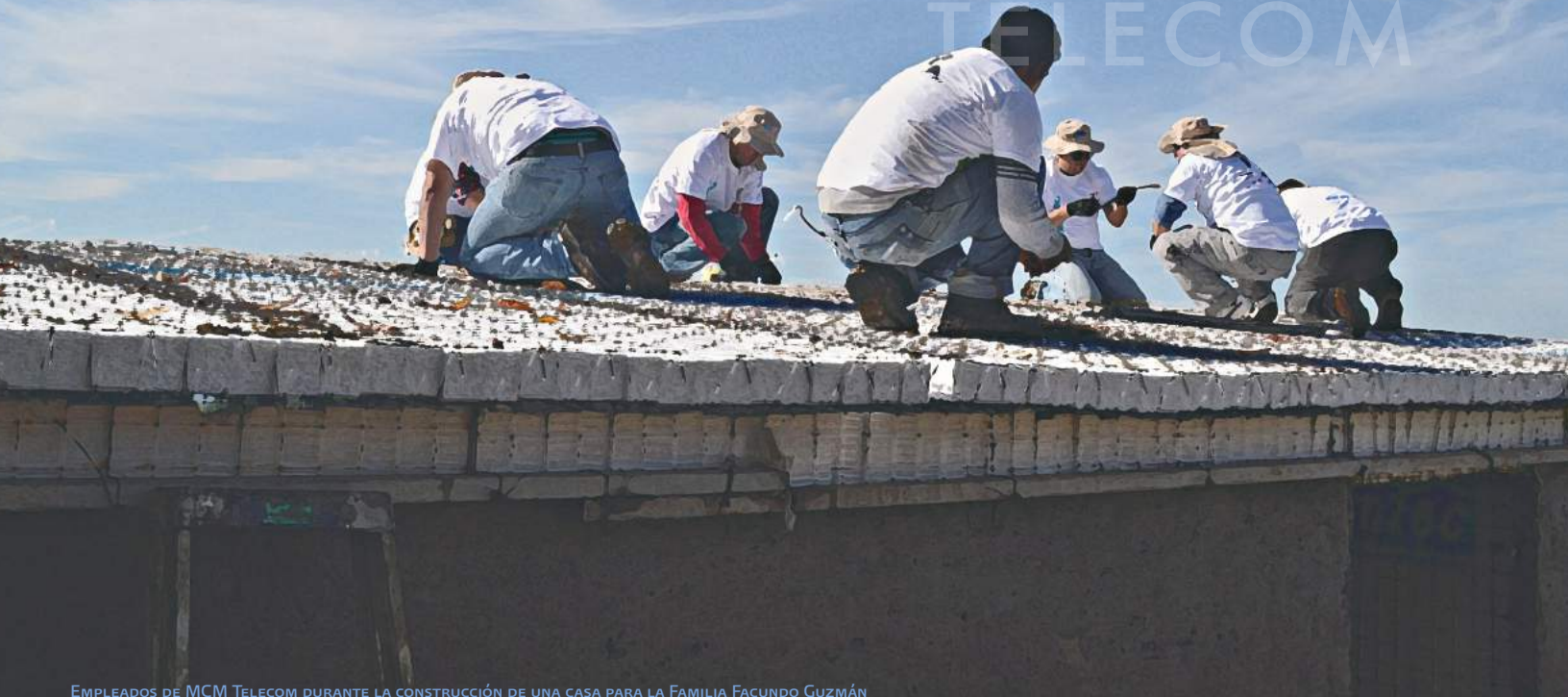
EMPLEADOS DE MCM TELECOM DURANTE LA CONSTRUCCIÓN DE UNA CASA PARA LA FAMILIA FACUNDO GUZMÁN
